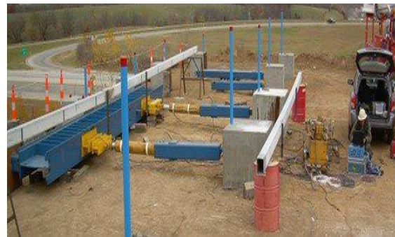
Fig: Horizontal load test on piles
